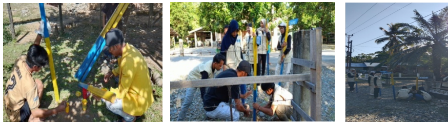
Gambar 7. Proses Pemuatan Dan Pemasangan Palang Desa
